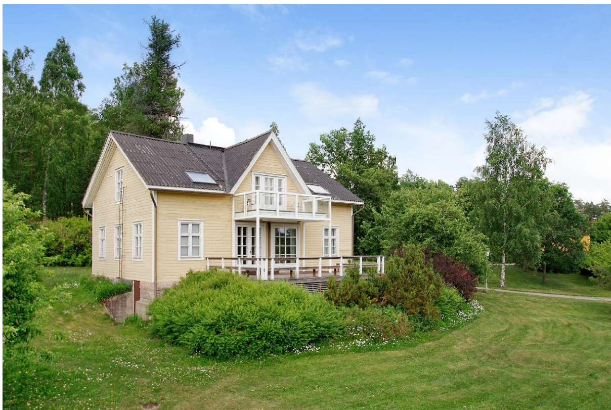
Huvilarakennus on graniittikiville perustettu ja vaakalaudoin verhottu 1900-luvun alun rakennus.
