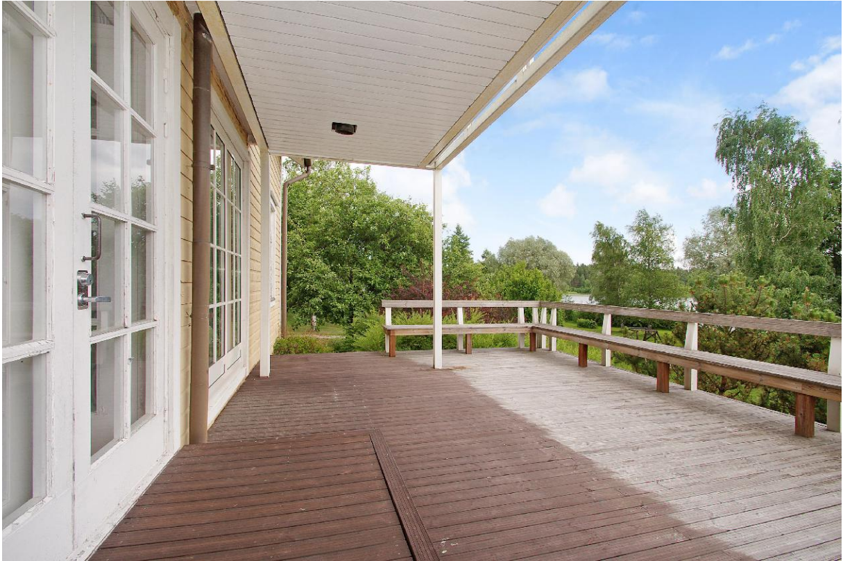
Huvilarakennuksen eteläpuolelle on sittemmin rakennettu terassirakennelma rakennuksen molempiin kerroksiin.
